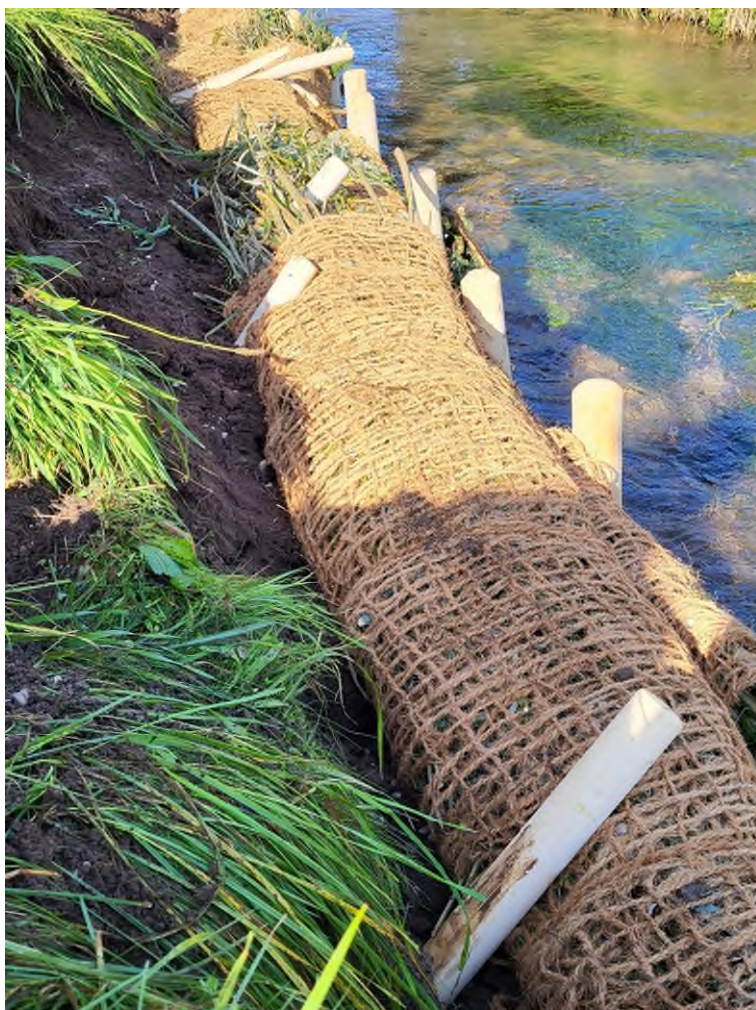
Abbildung 2: In einer Reihe haben die Studenten der Universität Weihenstephan-Triesdorf die Kokossenkwalzen an der Uferböschung der Sur bei Teisendorf verbaut. Die Walzen bestehen aus Weidenästen und Kies. Sie werden in Kokosmatten eingewickelt und fest verschnürt. Foto: Wasserwirtschaftsamt Traunstein
