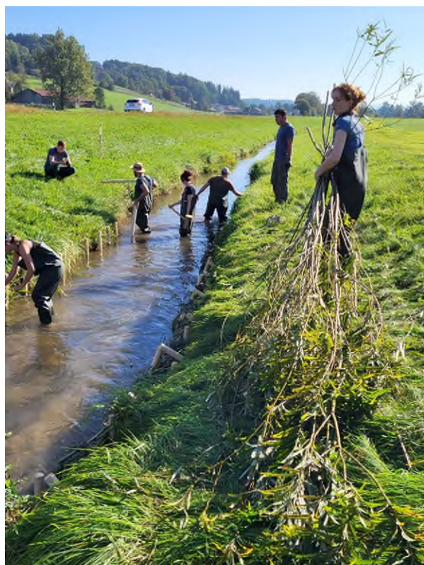
Abbildung 1: Hand in Hand arbeiten die jungen Studenten der Universität Weihenstephan-Triesdorf an den Ufern der Sur bei Teisendorf. Gemeinsam wollen sie im Rahmen der Lehrbaustelle die Ufer des Bachs sichern und verwenden dafür natürliche Materialien. Foto: Wasserwirtschaftsamt Traunstein
